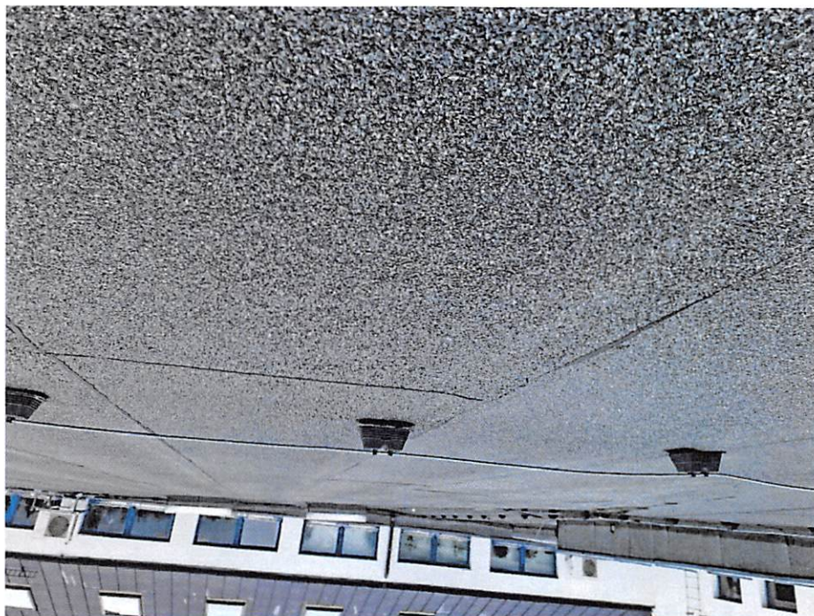
Zdjęcie 5. Odklejone klocki instalacji odgromowej.
