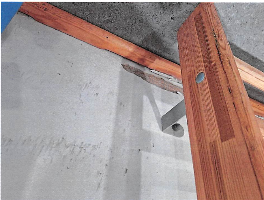
Zdjęcie 33. Zawilgocona dolna część ściany na sali gimnastycznej (ściana po stronie zewnętrznej) bezpośrednio przy wypiętej rurze kanalizacji deszczowej).
