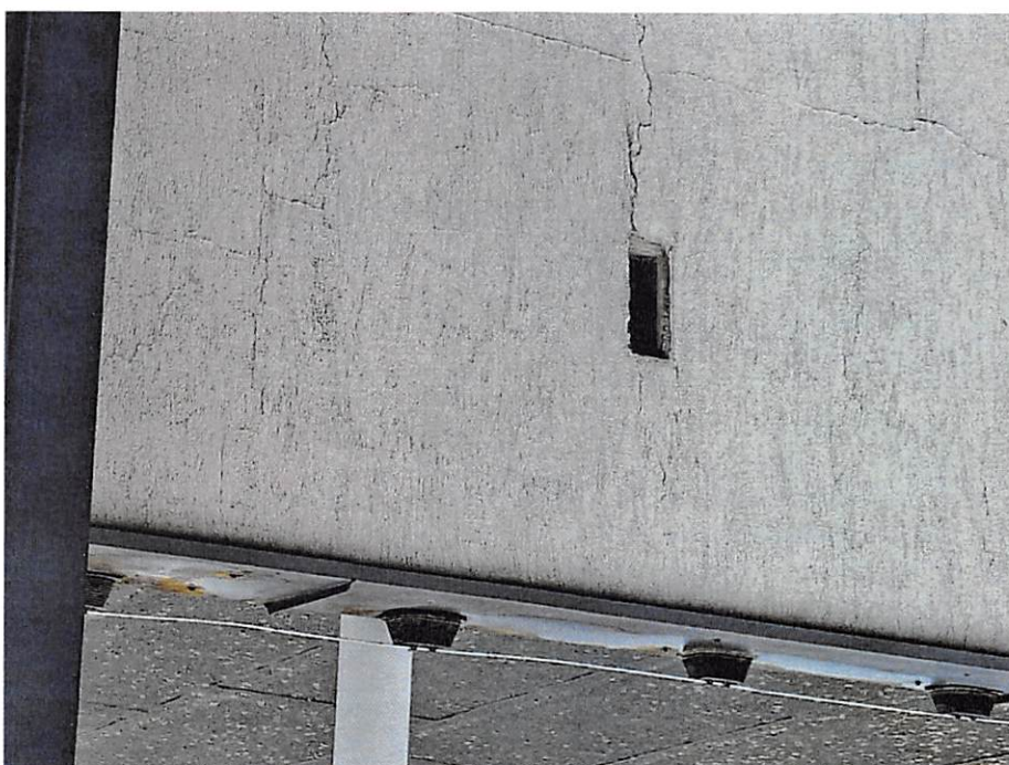
Zdjęcie 8. Brak kratki wentylacyjnej na elewacji przy wejściu głównym do budynku.
