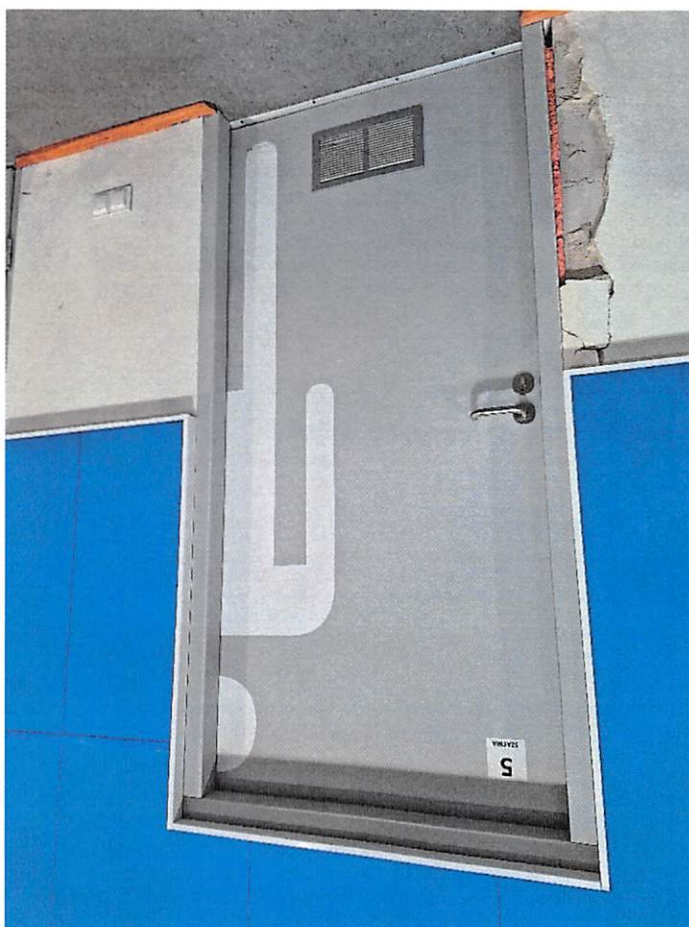
Zdjęcie 31. Uszkodzony fragment ściany przy drzwiach do toalety męskiej przy sali gimnastycznej.
