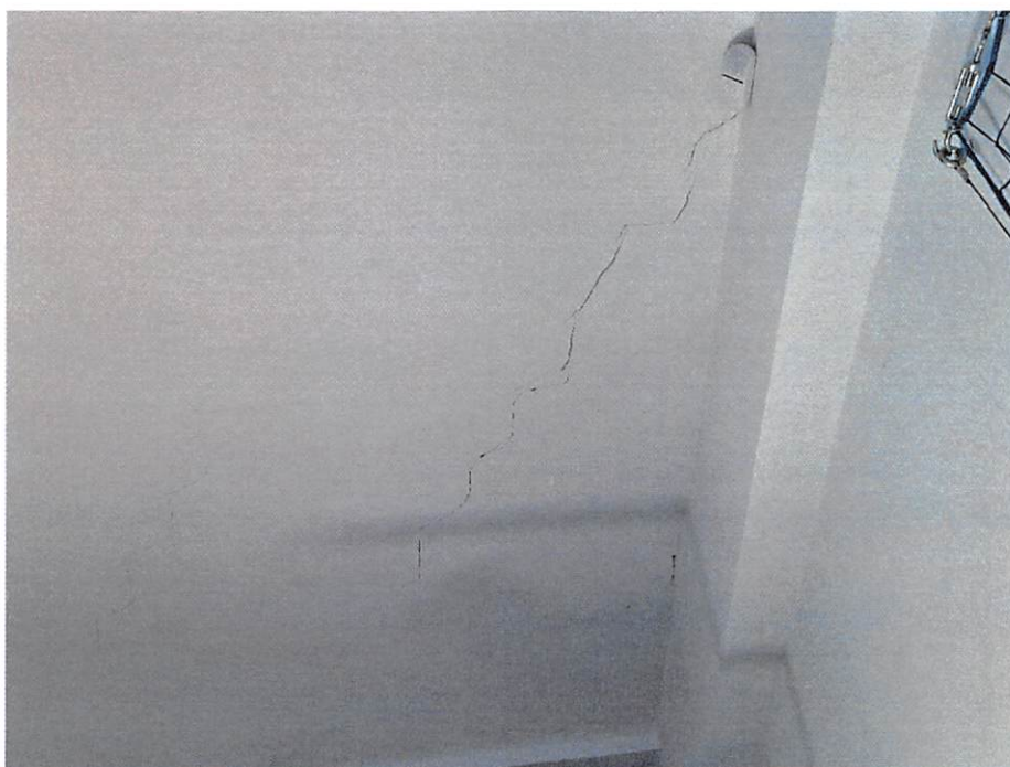
Zdjęcie 27. Pęknięcia ściany widoczne na ścianie szczytowej w sali gimnastycznej.
