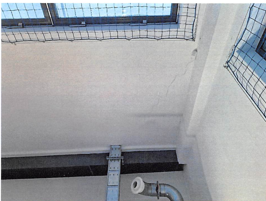
Zdjęcie 26. Pęknięcia ściany widoczne na ścianie szczytowej w sali gimnastycznej.
