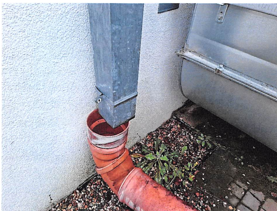
Zdjęcie 23. Wypięta rura kanalizacji deszczowej przy elewacji południowo-wschodniej sali gimnastycznej.
