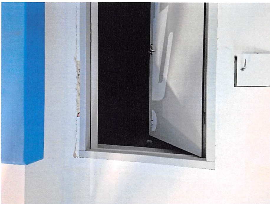
Zdjęcie 32. Uszkodzony fragment ściany przy drzwiach do toalety damskiej przy sali gimnastycznej.
