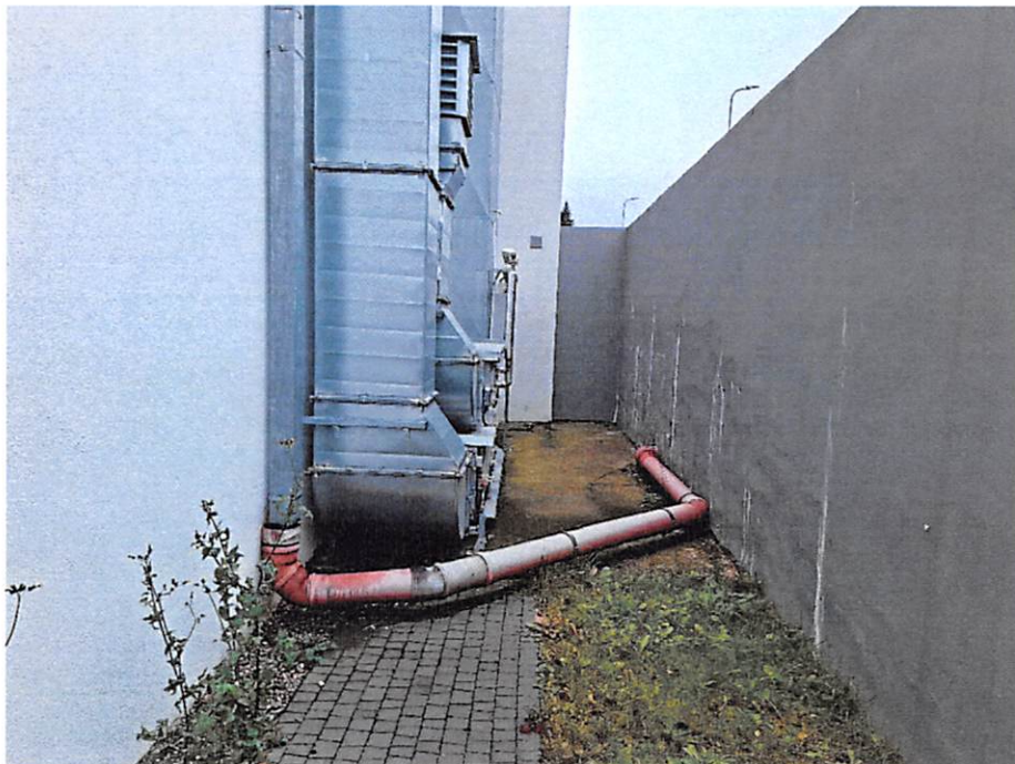
Zdjęcie 22. Wypięta rura kanalizacji deszczowej przy elewacji południowo-wschodniej sali gimnastycznej.
