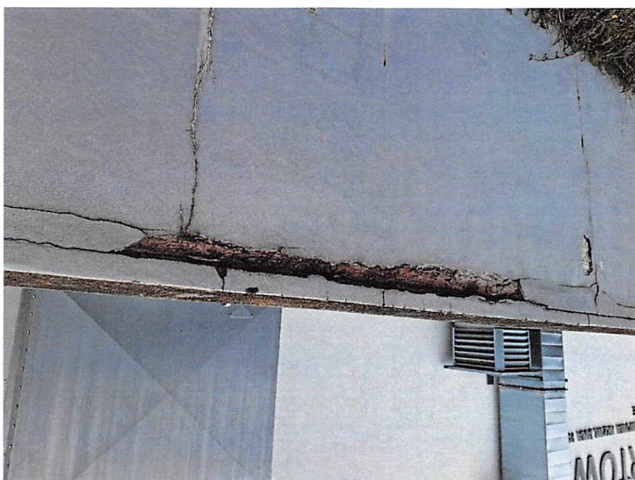
Zdjęcie 20. Odspojony tynk na murze oporowym przy sali gimnastycznej.
