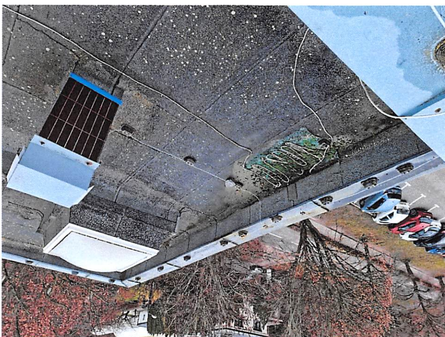
Zdjęcie 2. Silnie zanieczyszczony przez mchy rejon wpustu dachowego.
