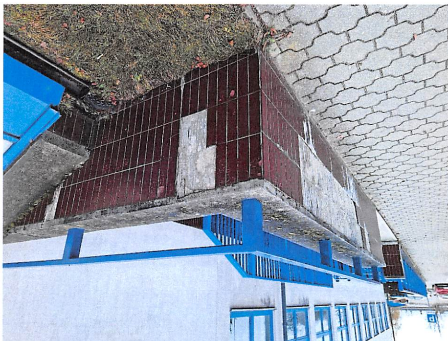
Zdjęcie 19. Odspożone płytki ceramiczne na murkach wokół budynku.
