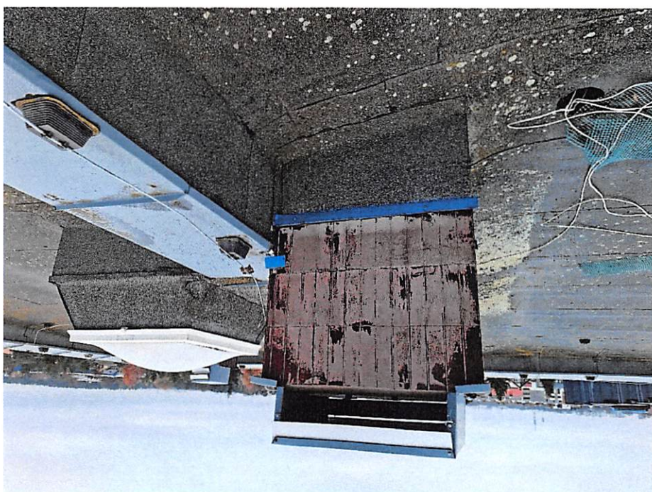
Zdjęcie 4. Zabrudzone płytki klinkierowe na kominach.
