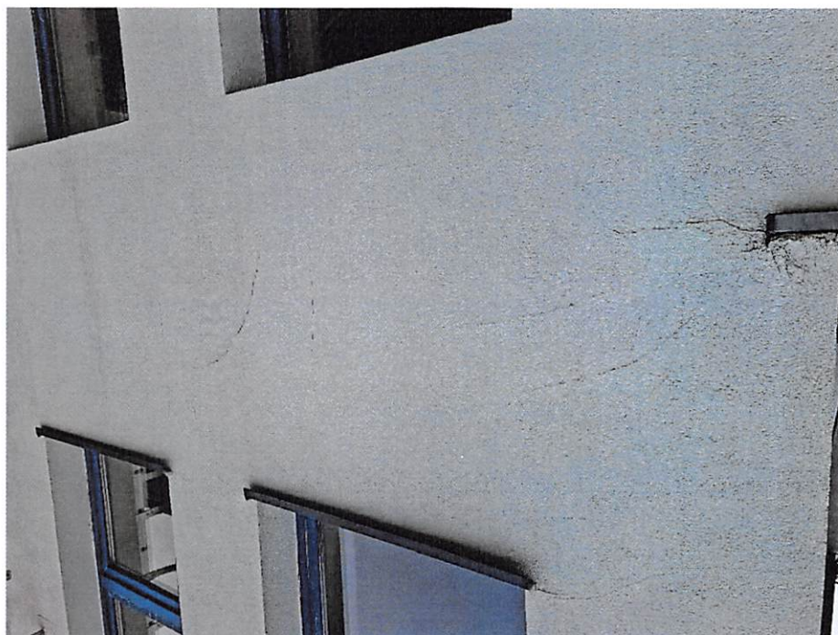
Zdjęcie 11. Pęknięcia tynku na elewacji przy dachu nad salą gimnastyczną.
