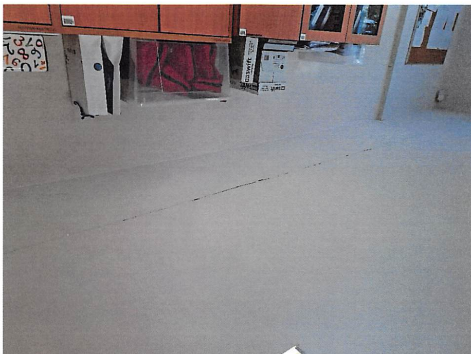
Zdjęcie 30. Pęknięcie sufitu tynkowanego na łączeniu płyt stropowych.
