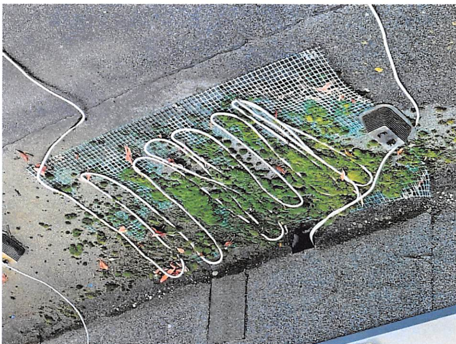
Zdjęcie 3. Silnie zanieczyszczony przez mchy rejon wpustu dachowego.
